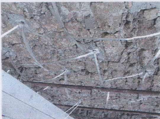
Foto 4: presentazione per campo di parete delle fascette attraverso le forature di cucitura e collegamento
