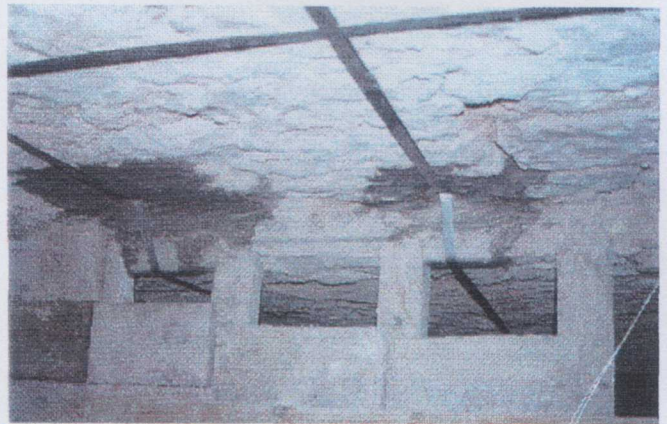
Foto 9: vista dell'intradosso di un solaio con evidenza del collegamento verticale tra la parete sottostante e quella di spiccato.
