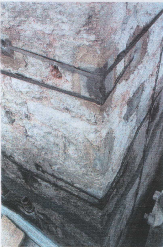
Foto 10: particolare del collegamento di due pareti convergenti con ripartitori d'angolo e elementi imbutiti. Da notare lo sfalsamento dei livelli di legatura.
