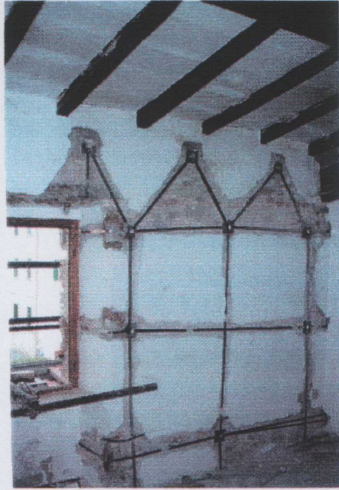
Foto 14: si apprezza la posa lungo le tracce d'intonaco con continuità verticale del collegamento fino al cordolo
