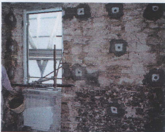
Foto 1: preparazione di una parete con presentazione degli elementi imbutiti e degli angolari.
