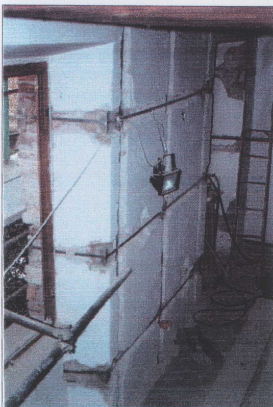
Foto 2: disposizione delle maglie su preparazione per tracce, senza rimozione completa dell'intonaco.
